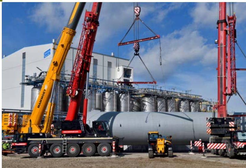
Die Schwerlastkräne beim Einheben des Tanks
